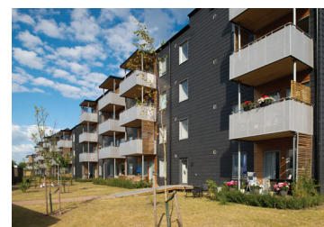
BoKlok Glasörten, Malmö, Sweden
